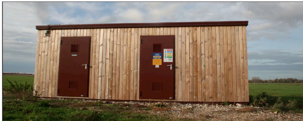
Exemple-type de poste de livraison
